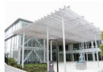
東京科学大学蔵前会館 (2009年、意匠：坂本一成／構造：竹内徹) Science Tokyo Front (2009, design by Kazunari Sakamoto / structure by Toru Takeuchi)
