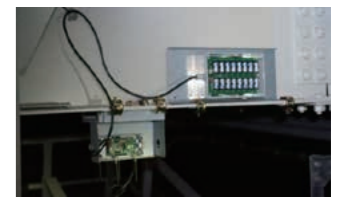
橋梁等実スケール構造物の計測技術の検討の例 (ワイヤレスモニタリングセンサ) Example of measurement technology for bridges and other actual-scale structures (Wireless monitoring sensor)
