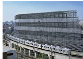
環境エネルギーイノベーション棟 (2012年、意匠：塚本由晴／構造：竹内徹／環境：伊原学、湯浅和博) Environmental Energy Innovation Bldg. (2012, design by Yoshiharu Tsukamoto / structure by Toru Takeuchi / environment by Manabu Ihara, Kazuhiko Yuasa)
