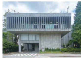
事務局1号館 (1967年、意匠：清家清) Administration Bureau Bldg. 1 (1967, design by Kiyoshi Seike)
