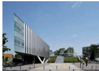
東京科学大学大岡山図書館 (2011年、意匠：安田幸一／構造：竹内徹) Ookayama Library (2011, design by Koichi Yasuda / structure by Toru Takeuchi)
